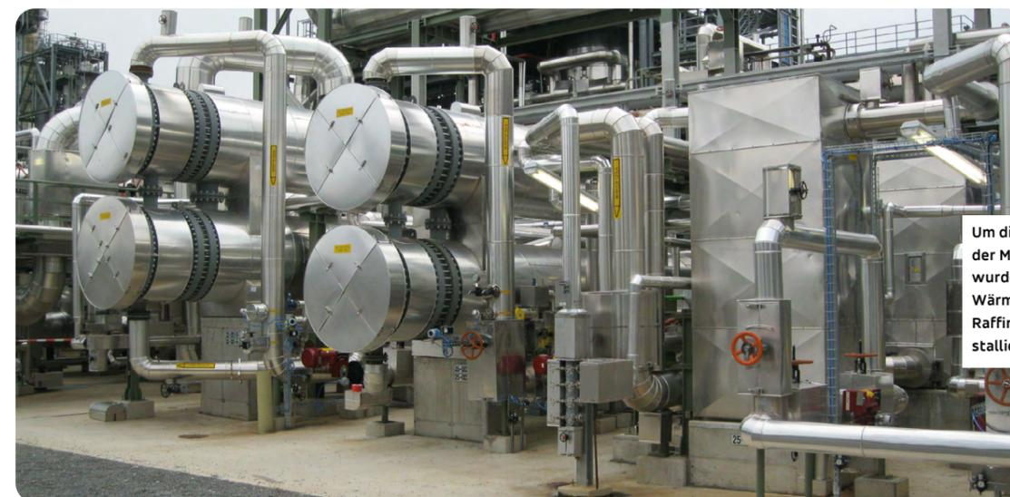
Um die Prozessabwärme der MiRO einzusammeln, wurden hochmoderne Wärmetauscher auf dem Raffineriegelände installiert.
