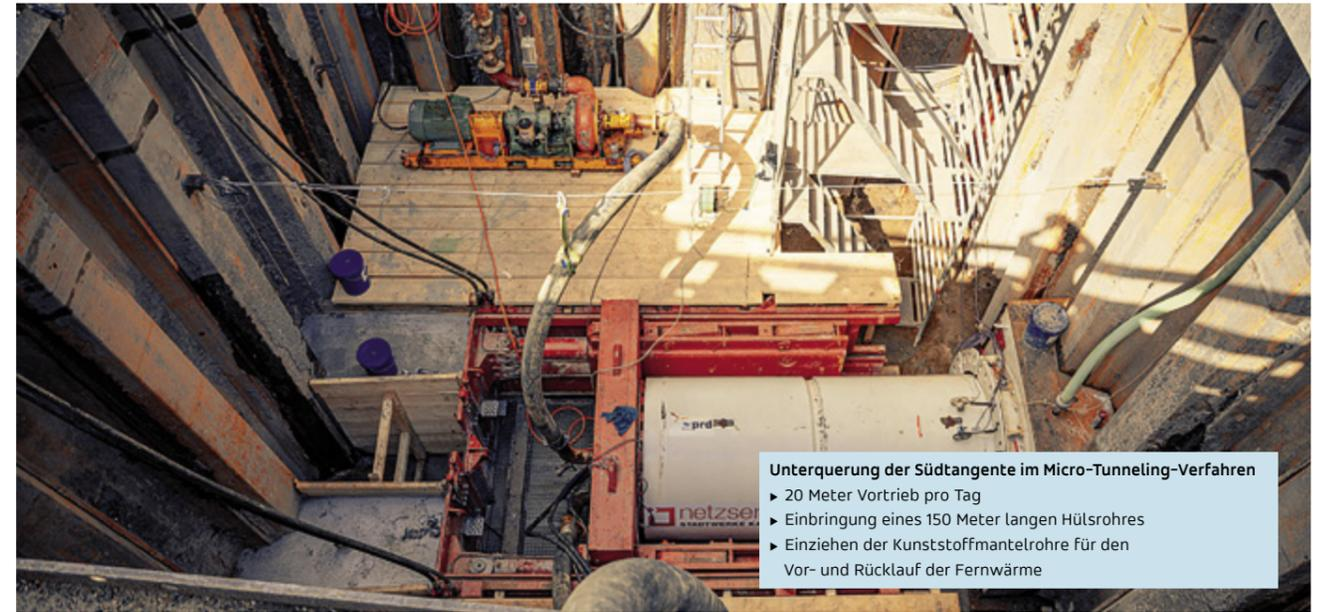
**Unterquerung der Südtangente im Micro-Tunneling-Verfahren**
