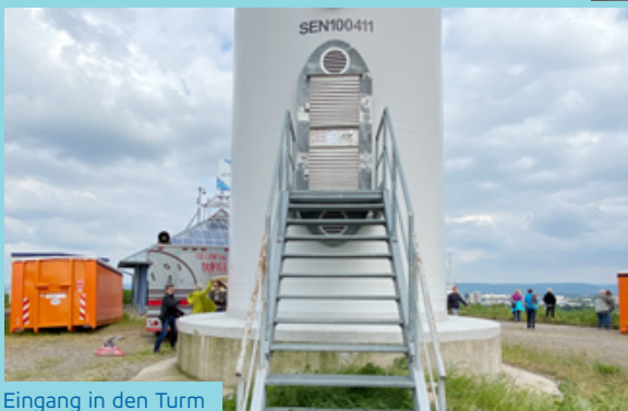
Eingang in den Turm
